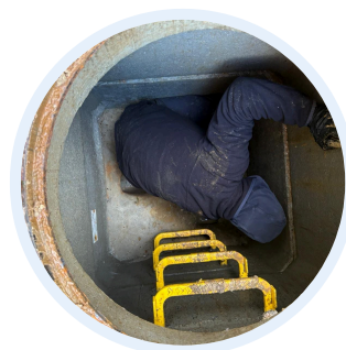
Intervention en regard
